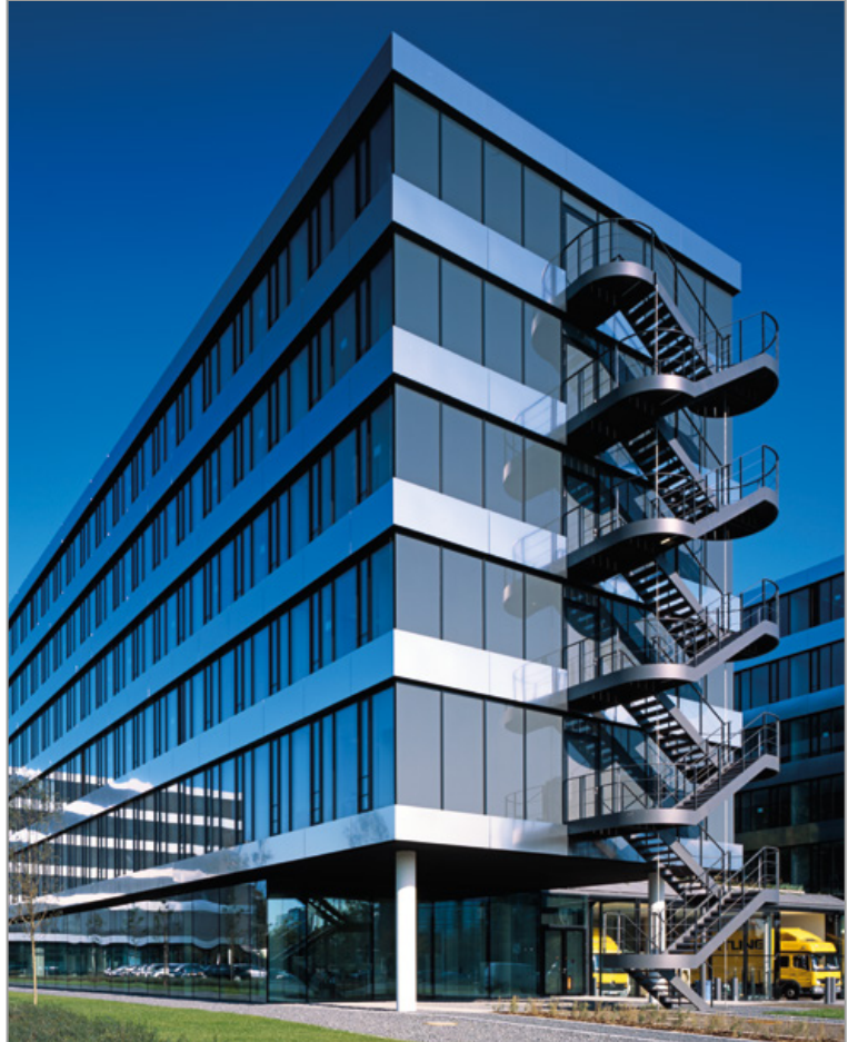
Klebeverbindungen wurden inzwischen auch im Fassadenbau erfolgreich eingesetzt. Foto: Ebener, Bad Marienberg (D)
